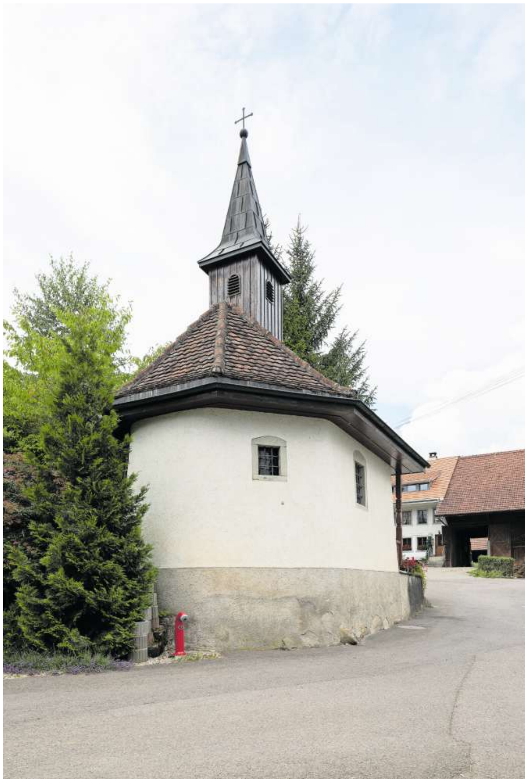
Der Husemer Baumeister Heini Burger errichtete die Annakapelle 1704 mitten im Weiler. Bild: Severin Bigler
